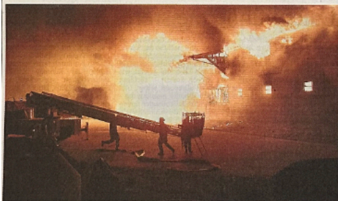
Momente des Schreckens: Knallend und krachend brach die riesige Lagerhalle an der Handfröste am Mittwochabend im Feuer in sich zusammen.
